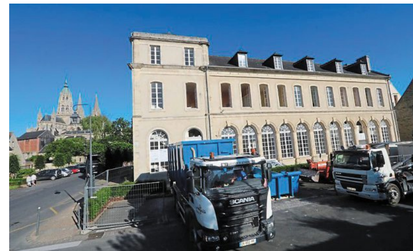
Les travaux ont commencé depuis quelques jours, pour transformer l'ancien tribunal en hôtel de luxe. En mai 2019, le bâtiment abritera quatre suites de grand standing.
